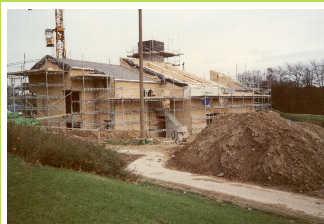
Kirkebyggeriet er i gang, og huset tager langsomt form. Tårnet begynder at rejse sig, og det er ved at være tid til rejsegilde. En del af byggeriet krævede en stor byggekran, der kan ses bag kirken på billedet.
