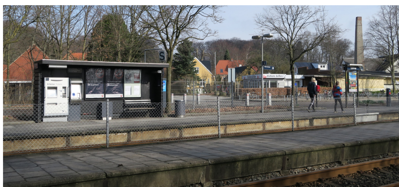
Stationen og kroen nedrevet. Hvor kroen lå, blev der 1981 bygget 4 dobbelthuse på Lystrup Stationsvej 4 af Gudmund Nielsen. Stationen er erstattet af et trinbræt og et læskur.
