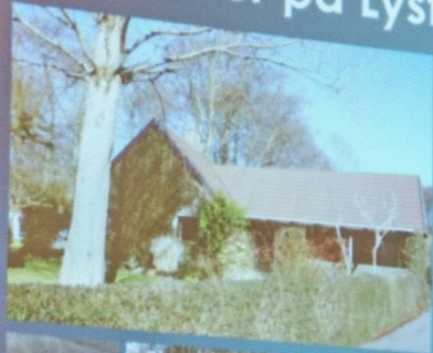
Bygaden 13, (før nedrivning 2009)
