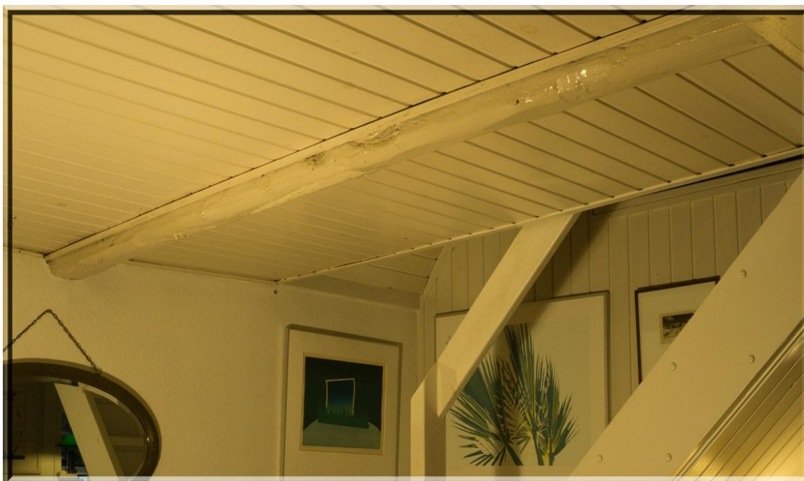
Behugget bjælke i stuen.
